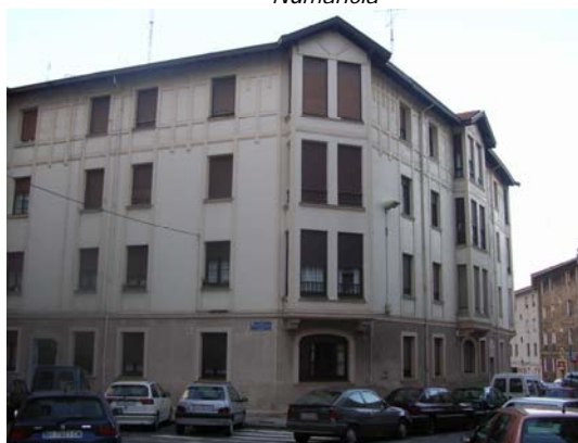
Fig. 7.8.- Vista actual de las viviendas de la Sociedad Numancia
