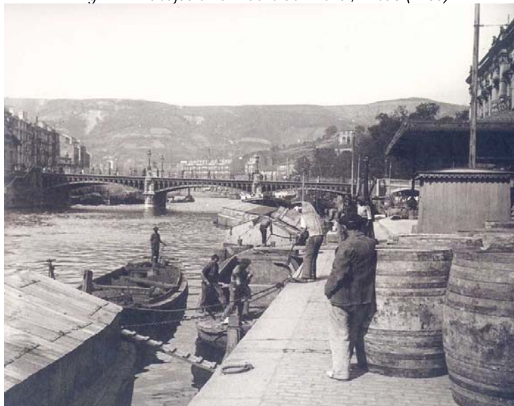
Fig. 1.2.-Trabajos en el Muelle del Arenal, Bilbao (1905)
