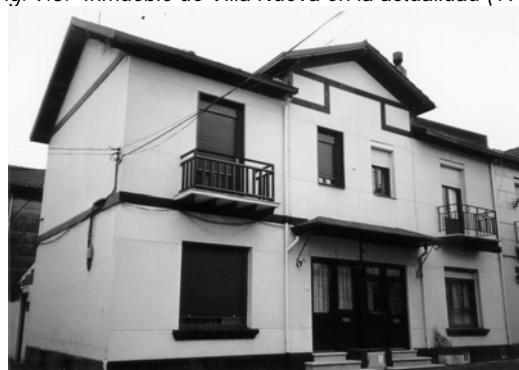
Fig. 9.3.- Inmueble de Villa Nueva en la actualidad (1997)
