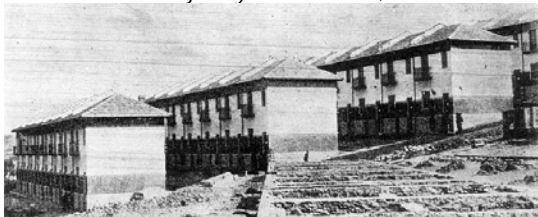
Fig.5.36.- Vista lateral de las viviendas de los Obreros de Castrejana y su desmonte, Bilbao
