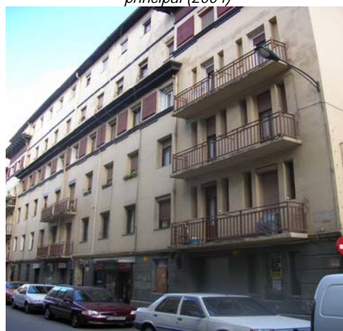
Fig. 6.31.- Los Ferroviarios en la actualidad. Fachada principal (2004)
