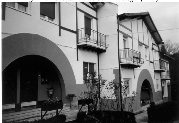
Fig. 7.25.- Casas Baratas de Alonsótegui (1997)
