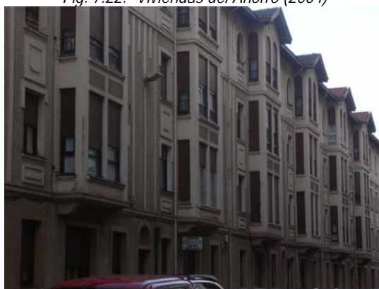
Fig. 7.22.- Viviendas del Ahorro (2004)
