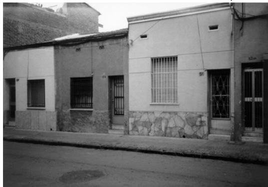
Fig. 11.9.- Viviendas del Sindicato Emisor de Cataluña, Tarrasa (1997)
