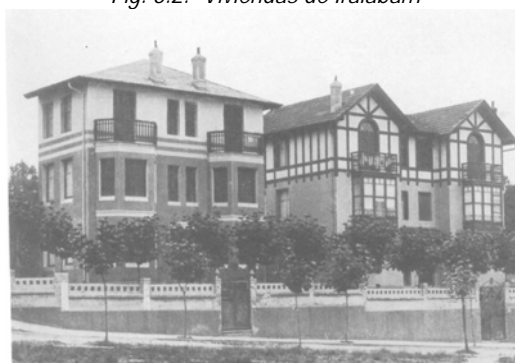
Fig. 6.2.- Viviendas de Iralabarri
