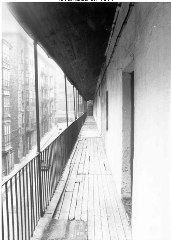
Fig. 2.2.- Corredor de la Casa “La Bomba”, Baracaldo, levantada en 1877
