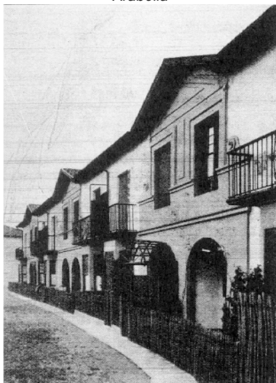
Fig. 6.39.- Vista lateral de las fachadas principales de Arabella
