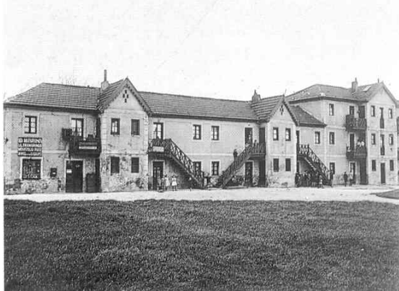
Fig. 2.15.- Conjunto antiguo de alojamientos para mineros erigido por la Cia. Luchana Mining en el barrio de Vitoricha (Baracaldo), c/ La Libertad
