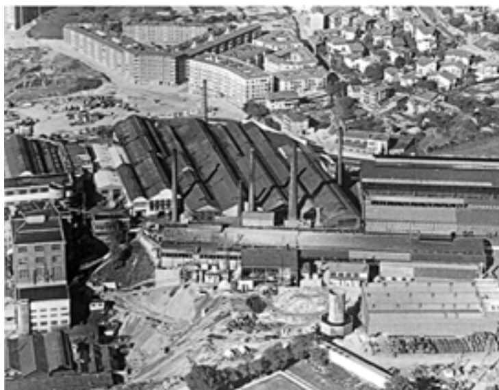
Fábrica de Echevarría. Solo queda el recuerdo y una de sus chimeneas de la que fue una avanzada en la fabricación de aceros de alta calidad.
