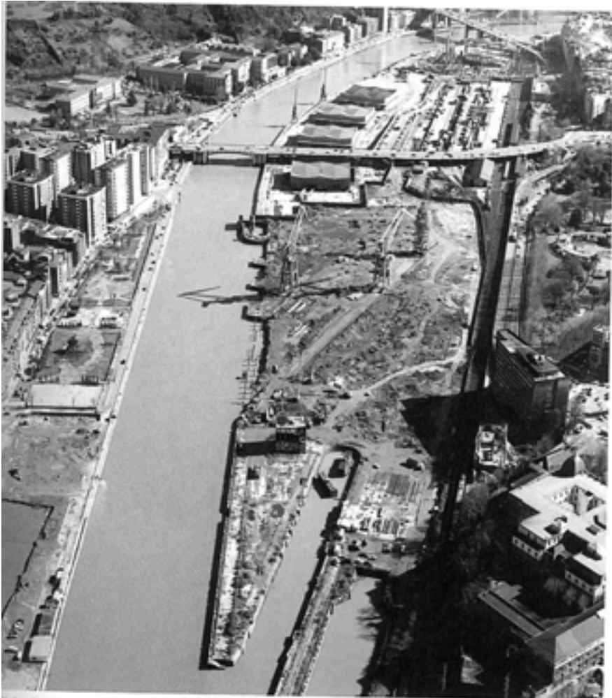
Actuación de demolición de ruinas practicada en las instalaciones de Euskalduna .
